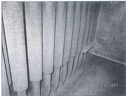
ภาพถ่ายภายใน Economizer ของหม้อไอน้ำ แสดง Finned Tube ที่อยู่ภายใน
