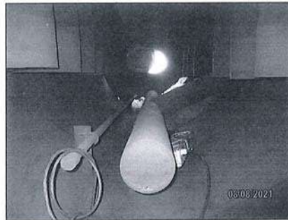
ภาพถ่ายภายใน Steam Drum ของหม้อไอน้ำ แบบให้เห็นชิ้นส่วนต่างๆที่อยู่ภายใน
