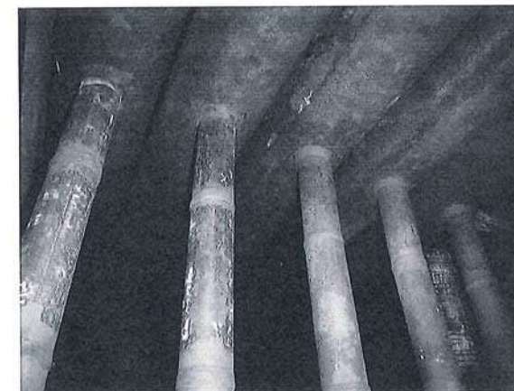
ภาพที่ 8 ภาพถ่ายแสดง การตรวจสอบ สภาพภายในหม้อไอน้ำ ขณะทำการอัดน้ำ Hydrostatic Test เพื่อทำการทดสอบหม้อไอน้ำ
