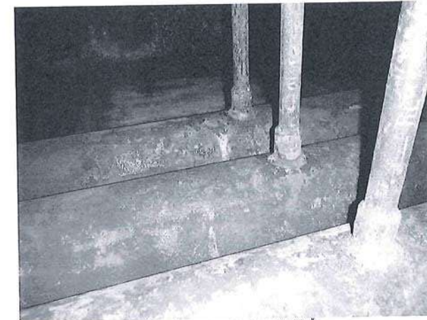
ภาพที่ 7 ภาพถ่ายแสดง การตรวจสอบ สภาพภายในหม้อไอน้ำ ขณะทำการอัดน้ำ Hydrostatic Test เพื่อทำการทดสอบหม้อไอน้ำ
